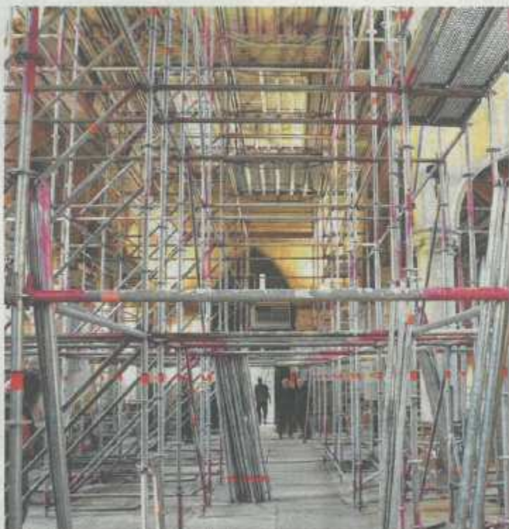
De buizenconstructie in de kerk. FOTO ERIK VANDEWALLE
