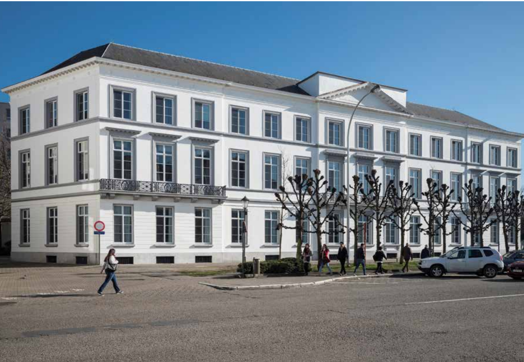
Restauratie Hof van Egmont te Mechelen
