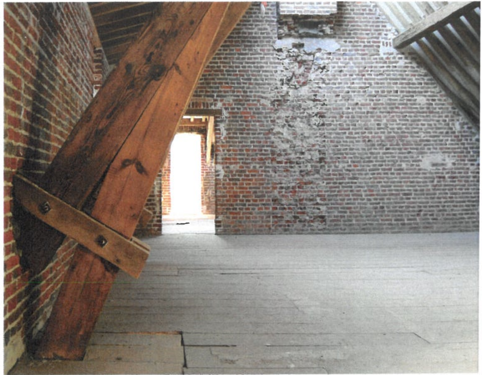
De aannemer heeft het dak van het kasteel volledig vernieuwd. Hij verving de asbestleien, bracht extra isolatie aan en renoveerde de houten structuur.
