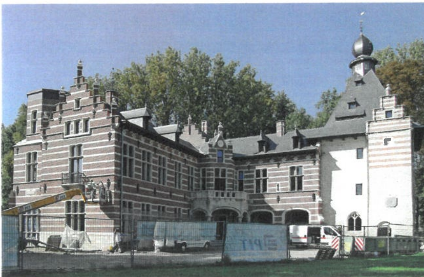
Het kasteel is in een L-vorm gebouwd. De donjon is in zandsteen opgetrokken, de rest van het kasteel is veel jonger en heeft vooral bakstenen muren.
