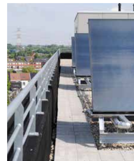
Per dak wordt er een zonneboilersysteem met achttien zonnepanelen geplaatst.
