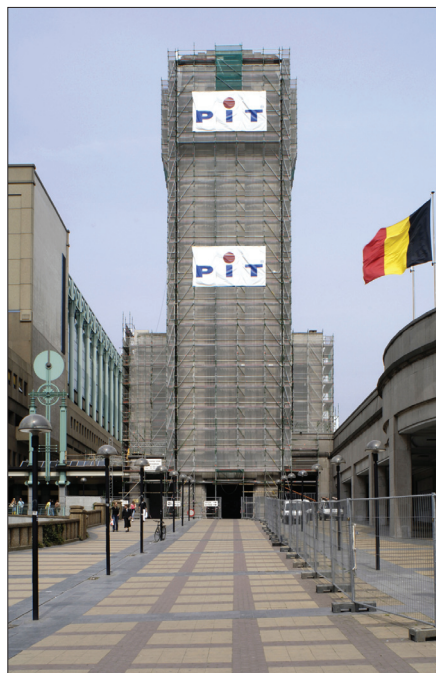
Het bedrijf uit Kapellen renoveert momenteel de gevels van het Noordstation in Brussel.
